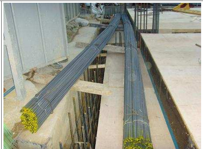
재해 당일 최초 하역한 철근 다발
